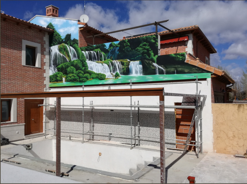
Exterior. Particular. Laguna de Duero, Valladolid 2020
